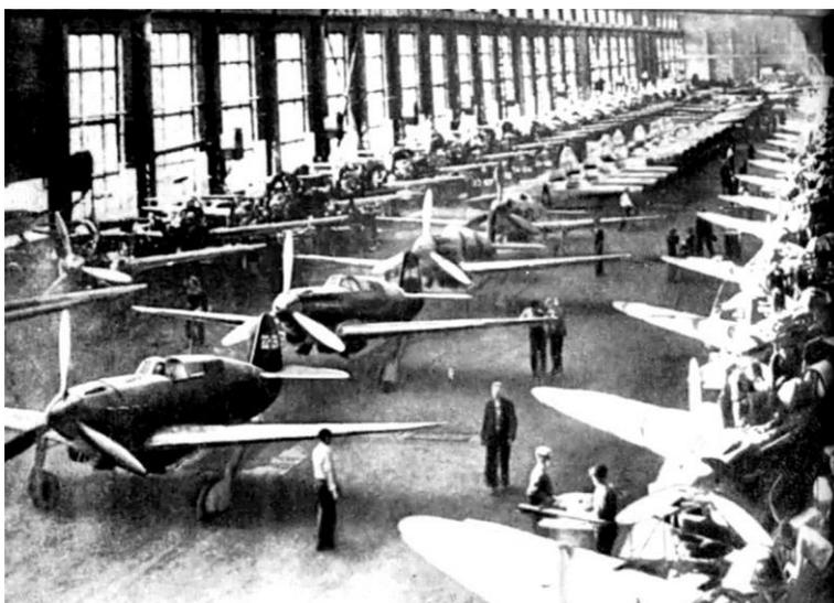
**Рис. 7. Конвейер сборки истребителей Як-7 в Новосибирске**
